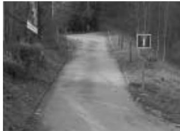
L'aménagement du chemin du Haut de Lesse est à présent achevé. Le tapis de chaussée est réalisé dans la montée et la partie haute dispose d'un revêtement bicouche. Les trottoirs sont également terminés ainsi que l'éclairage public. L'ensemble des riverains qui en avaient exprimé le désir bénéficient désormais d'un raccordement au gaz de ville et en sont satisfaits.
